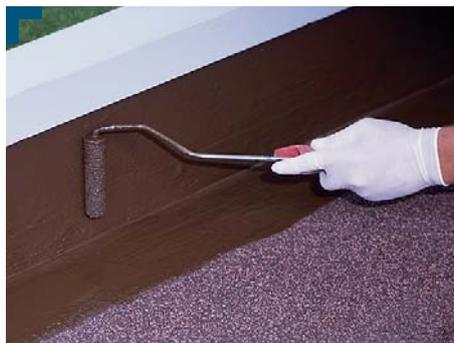
Applicazione del secondo strato **Flashing** (700 g/m²).
