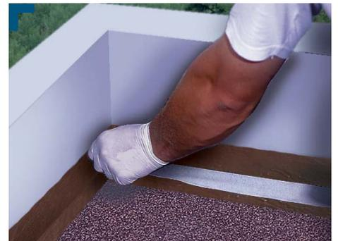
Incollaggio dell'armatura di rinforzo **Voile Flashing** (larghezza 10 cm) con **Flashing** (500 g/m²).
