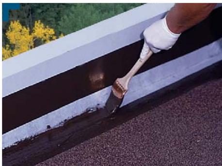
Applicazione del primo strato **Flashing** (900 g/m²).
