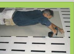
Le staffe presenti nel blocco permettono di fissare il rivestimento di finitura interna evitando di eseguire la struttura apposta
