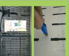
Gli impiantisti eseguono autonomamente, con un coltello caldo, le tracce in maniera sicura e veloce
