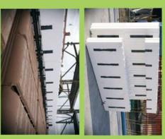
Nel realizzare il solaio non si interrompe la continuità dell'isolamento esterno, evitando così ponti termici, inoltre la spondina del solaio risulta già eseguita
